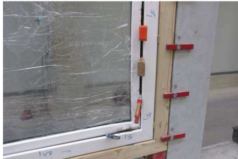
Bild 9 Schäden aus der manuellen Prüfung auf der Griffseite unten
