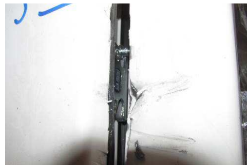
Bild 20 Schäden aus der manuellen Prüfung am Ecklager
